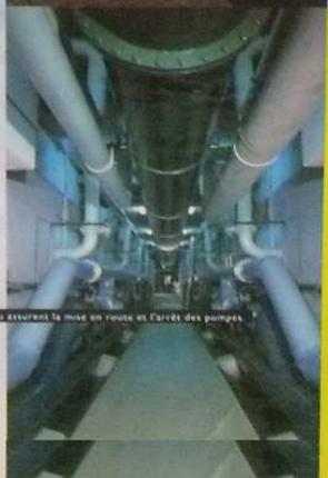
Dans les stations de pompage - des hortiques combinées à des capteurs de pression ou de niveau assurent la mise en route et l'arrêt des pompes.
