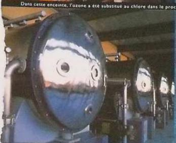
Dans cette enceinte, l'ozone a été substitué au chlore dans le processus de désinfection de l'eau.
